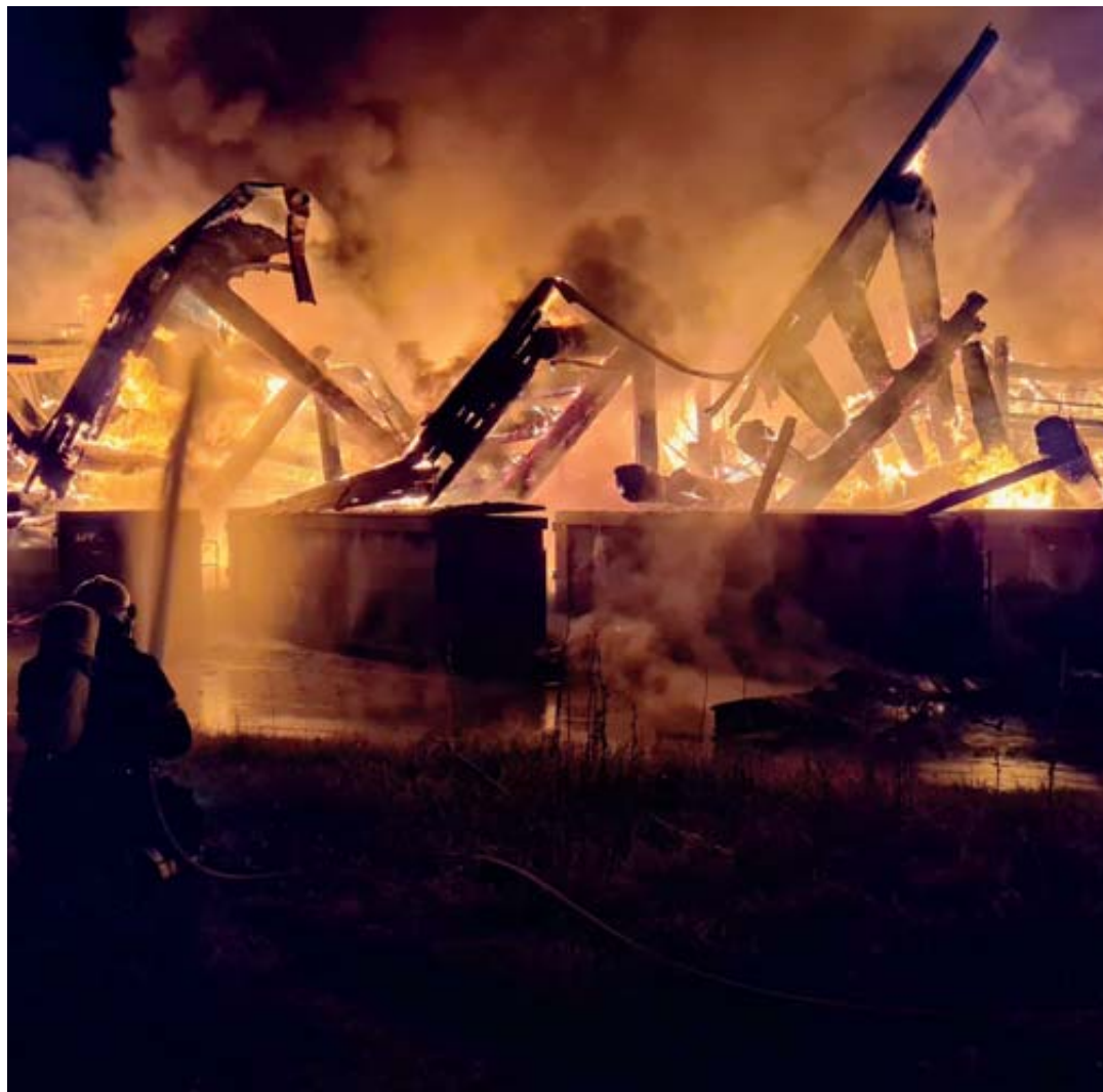
A l'arrivée des pompiers, lundi à 2h45, l'incendie avait déjà atteint l'entier du bâtiment inauguré en 2011. Les soldats du feu se sont alors concentrés sur la protection des constructions voisines. SIS MORGET
